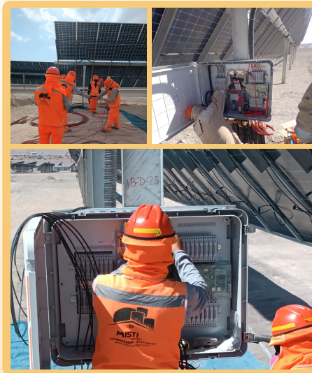
TENDIDO Y CONEXIONADO DE CABLE SOLAR DE BT Y MT
