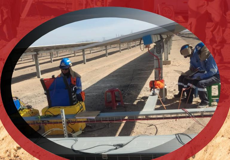
**Prueba de resistencia a tierra en cables de cobre**
